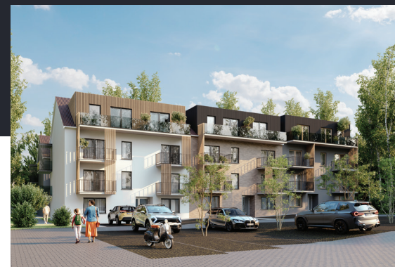
Widok budynku od strony ulicy
