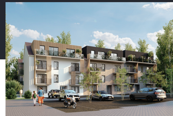
Widok budynku od strony ulicy
