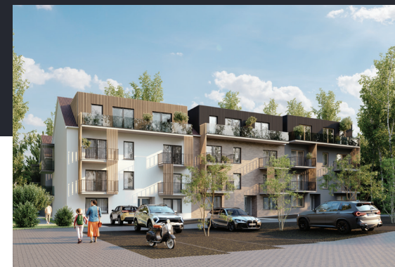
Widok budynku od strony ulicy
