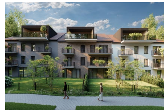
Widok budynku od tyłu
